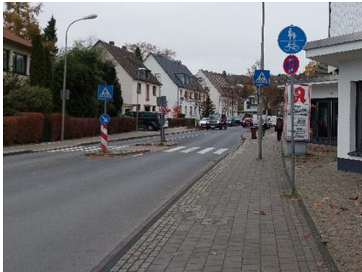
Abbildung 4-7: Untermaßiger benutzungspflichtiger gemeinsamer Geh-Radweg in der Montanusstraße 36 Zu beachten ist der eingebaute Lichtmast auf dem Radweg!
