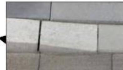
Übergangstein 3 links - Übergang von Tastsstein 6 cm auf Schrägstein mit Nullabsenkung
