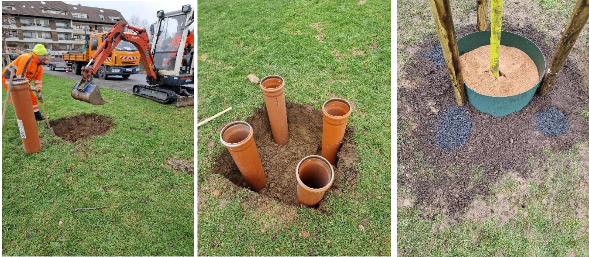
Abbildung 3-6: Splitt-Zylinder zur Förderung des Wurzelwachstums in Leichlingen (Bauhof Leichlingen, 2025)
